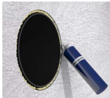
Abb. 5 Wandeinbaurohr abdichten
